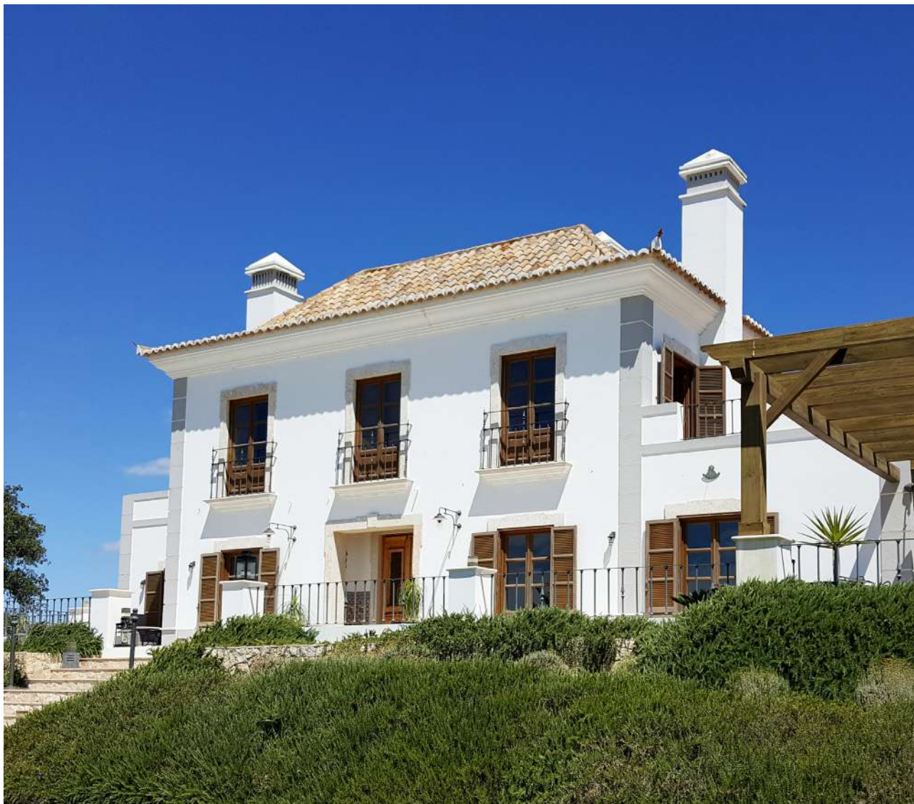
Rénovation complète des fenêtres, portes-fenêtres et volets de style traditionnel en chêne. Full house window replacement, keeping the traditional style of oak windows, exterior doors and shutters.
